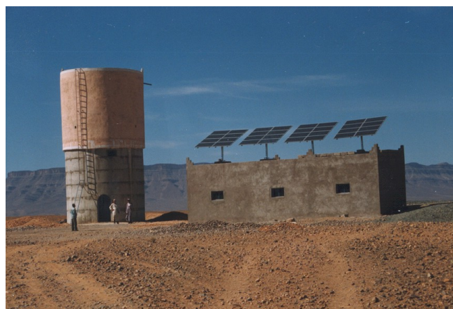
(B) Sistema de bombeo con depósito elevado.
